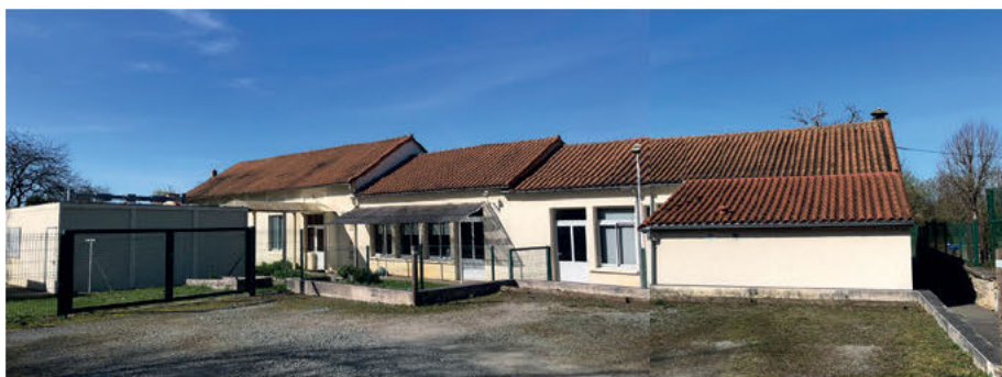
Vue arrière bâtiment principal - photo CAUE 79
