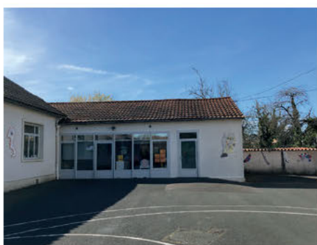
Vue aile ouest - photos CAUE 79
