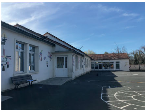
Vue façade nord bâtiment principal - photos CAUE 79
