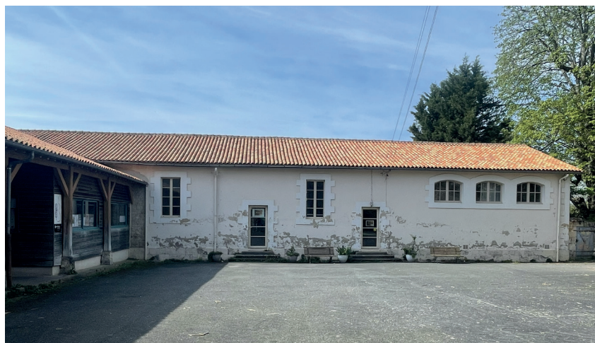
Vue sur l'école de musique depuis la cour ©CAUE79
