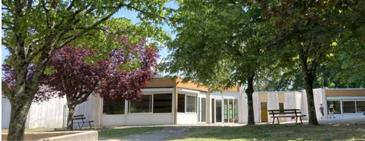
École de la Mara, Parthenay © CAUE79
